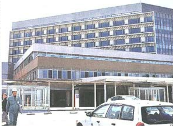
開院に向けて最終準備が進む中東遠総合医療センター 掛川市菟浦ヶ池
